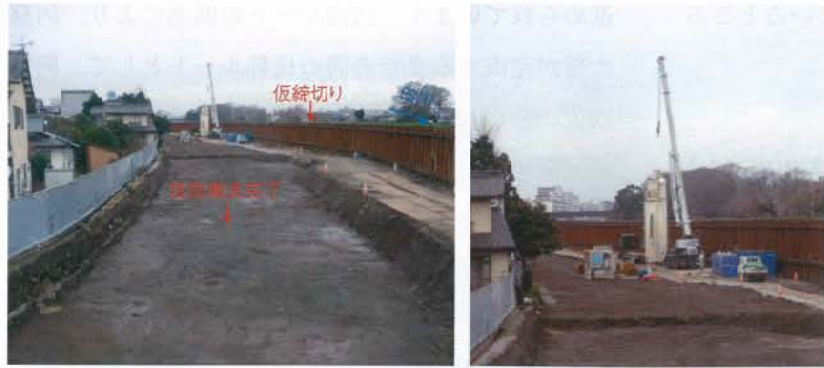
被災した堤防の撤去完了
