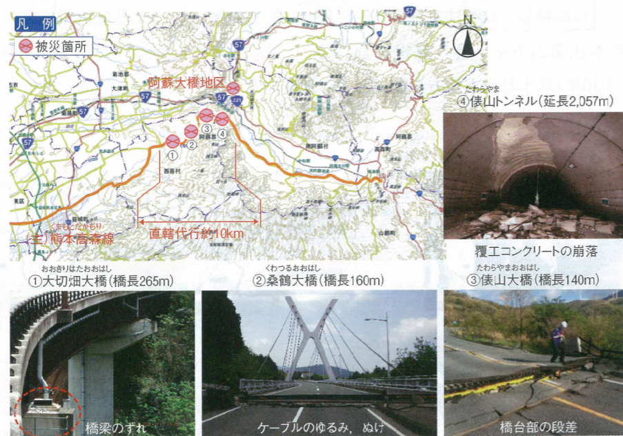
図4 県道28号熊本高森線の被災状況
