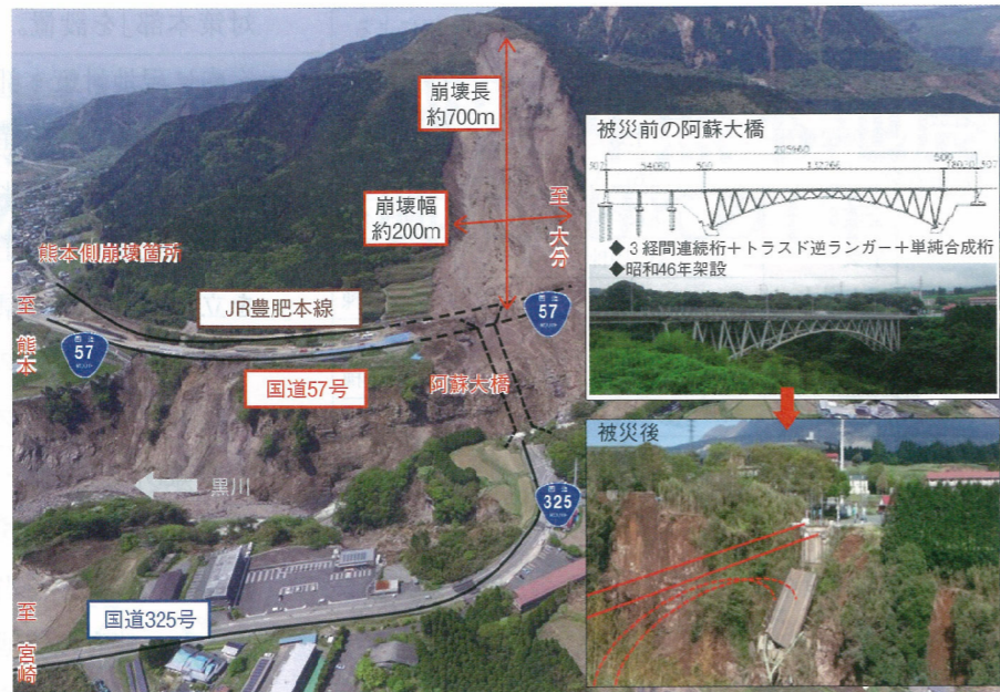
図3 阿蘇大橋地区の被災状況
