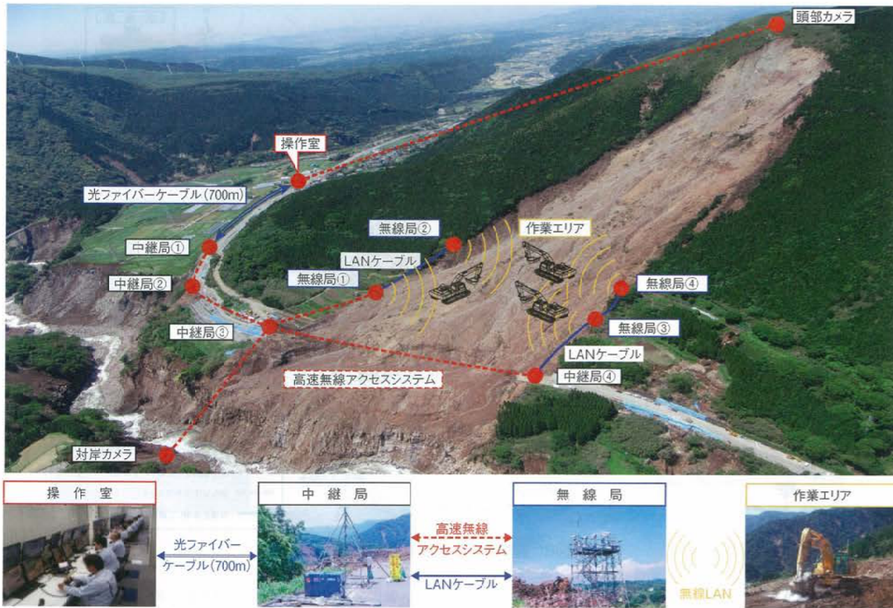
図10 ネットワーク型無人化施工システム
